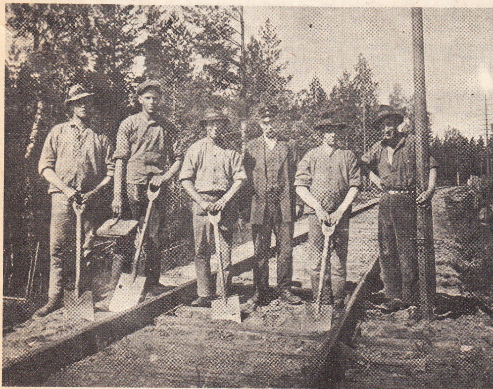
Ett arbetslag utmed bandelen Grycksbo — Sägmyra. Det är banvakten Cederberg som ställt upp med sitt arbetslag för fotografen. Bilden är tagen i trakten av Lustebo omkring 1920.
